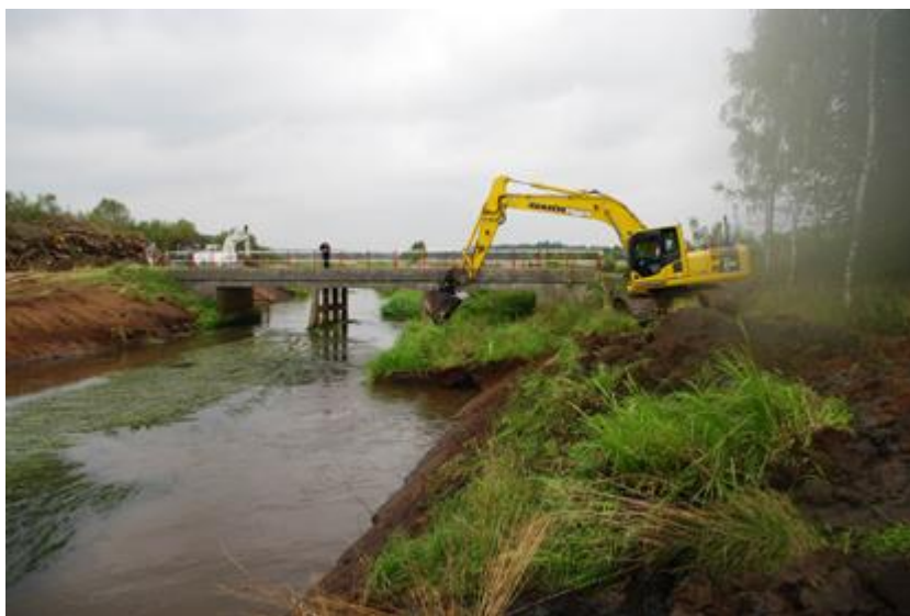
Jorden opgraves ved Karlsgårde Bro.
